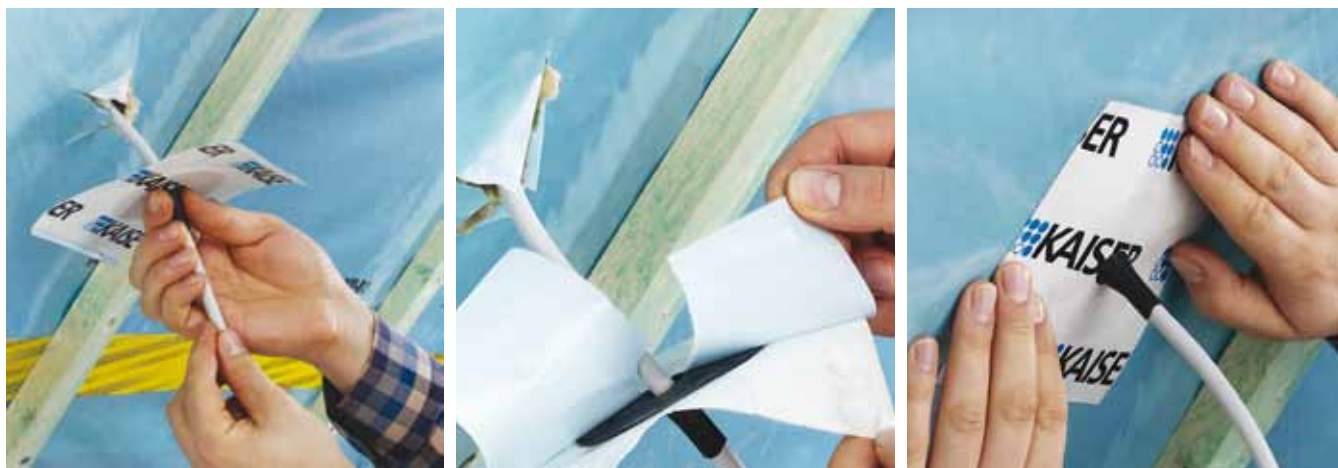
Bild 9: Luftdichte Durchführung einer Antennenleitung
