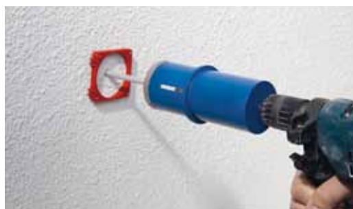
Bild 17: nachträglicher Einbau von Steckdosen in die gedämmte Außenfassade
