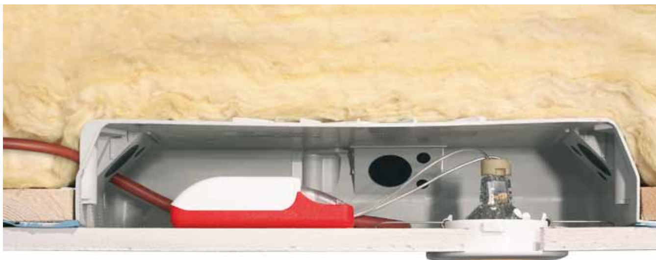
Bild 11: Gehäuse für Einbauleuchte ist luftdicht in die Dämmschicht integriert
