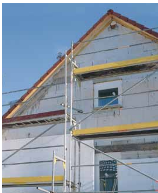
Bild 12: Dämmung der Außenfassade
