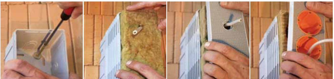
Bild 13: Universalgeräteträger für gedämmte Außenfassaden
